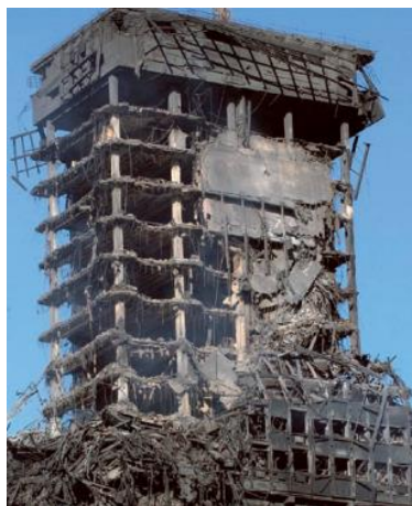
El edificio Windsor ardiendo. Fuente: IECA, España
