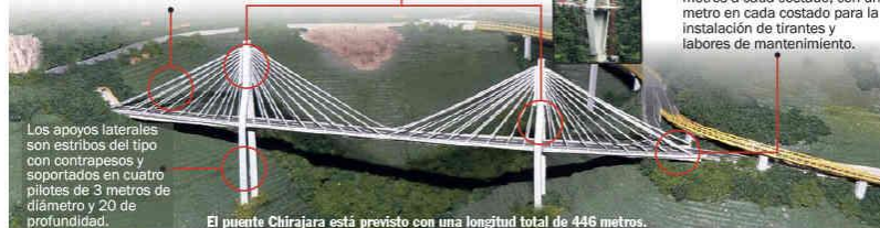
El puente Chirajara está previsto con una longitud total de 446 metros.
