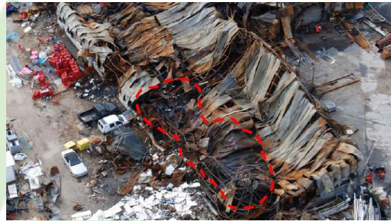
Afectación área norte nave 1
