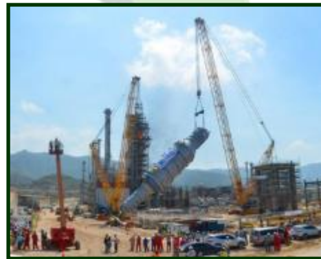
Montaje de una Torre de Destilación
