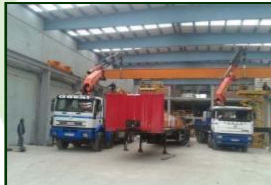
Montaje de un Puente Grúa
