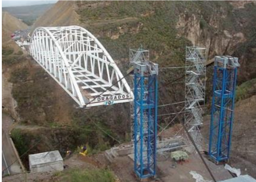
PROCESO HIBRIDO ENTRE UNA OBRA CIVIL Y UN MONTAJE
