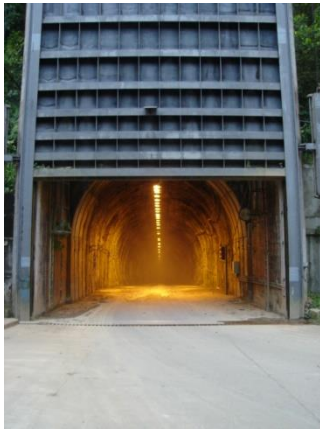
Acceso a Casa de Máquinas
